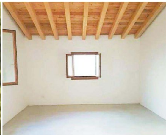
Uno degli ambienti dell'edificio a conclusione dei lavori di recupero
